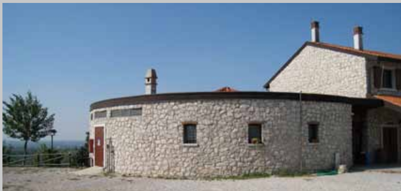
Centro visite Gradina
